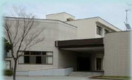
【基礎教育棟外壁改修】 財源:運営費交付金
