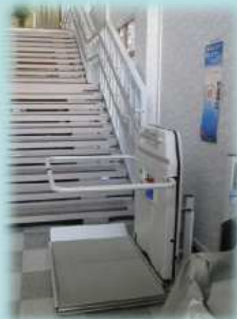
【松下会館階段昇降機設置】 財源:運営費交付金
