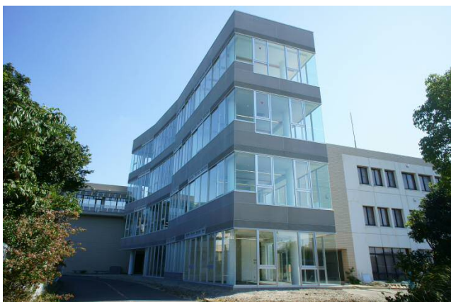
完成した附属図書館増築棟
