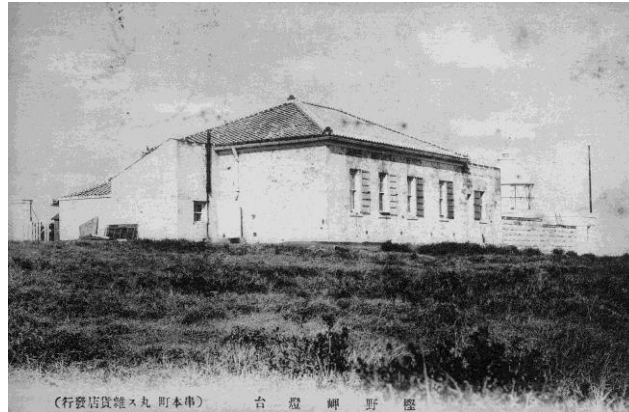
写真1 旧官舎全景が写る最古の写真(大正11年の消印)
