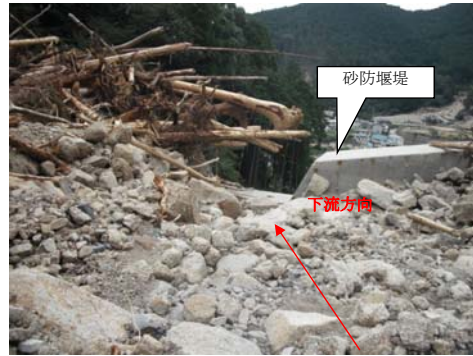
砂防堰堤背後の状況(満砂)
