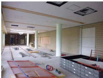
増築棟 2階。ここに電動書架がはいります。
