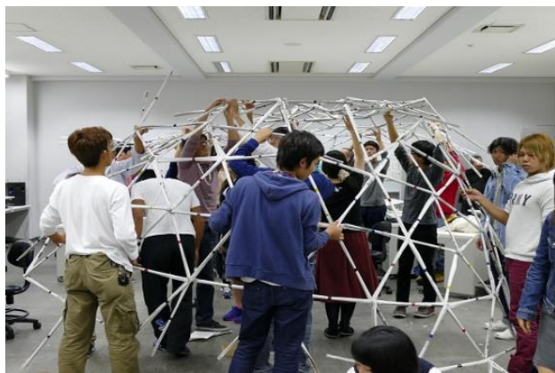
ジオデシックドームを作製する様子 (環境デザインメジャー)
