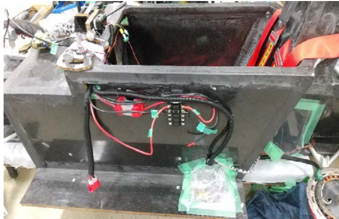
図 4 新車体への配線の実装
