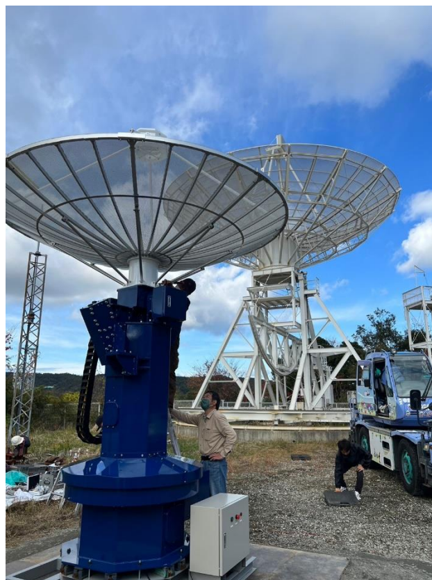
図 5 赤井工作所製作 3m パラボラアンテナ (手前)
