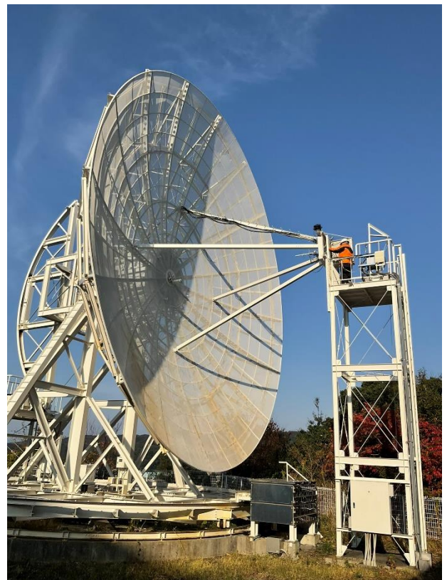
図 3 OMOTENASHI 対応機器への交換状況
