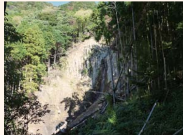
滝の多くは、たった1回の土石流によって岩盤が露出してできる。写真は、平成23年の災害の際「一夜」で新たに誕生した滝。まるで大蛇が這いずり回ってきた地形で、滝と蛇の関係が良く語られる理由もうなずける。
